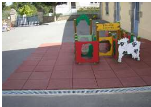
Création d'un caniveau dans la cour de l'école
