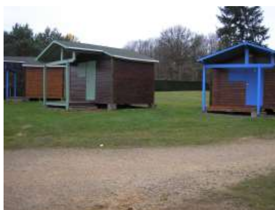
Réfection extérieure des chalets au camping
