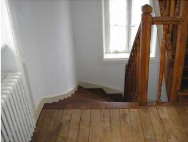
Rénovation du logement de La Poste
