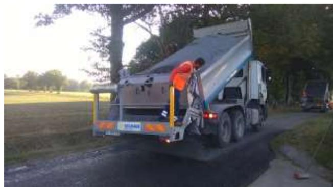
Les travaux de Grosses Réparations de Voirie Communale (GRVC) se sont déroulés au mois de septembre. C'est l'entreprise SIORAT qui a obtenu le marché pour 2018. Le montant de ces travaux est de 67 516,25 € TTC pour 1,9 kilomètre de voirie renforcée et refaite en tri couches subventionnés à hauteur de 40 % par le Département.
